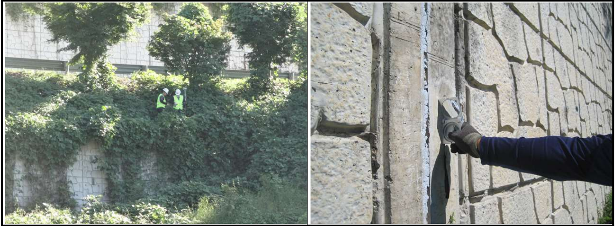
【그림 11.3.3】 측량작업 전경(콘크리트옹벽)
