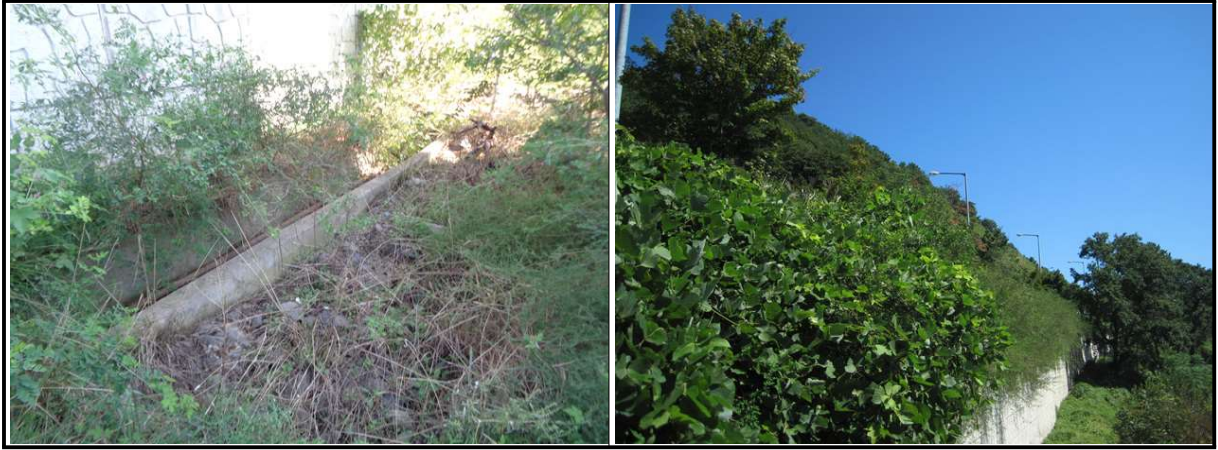
【그림 11.3.2】 주변영향인자 전경(콘크리트옹벽)
