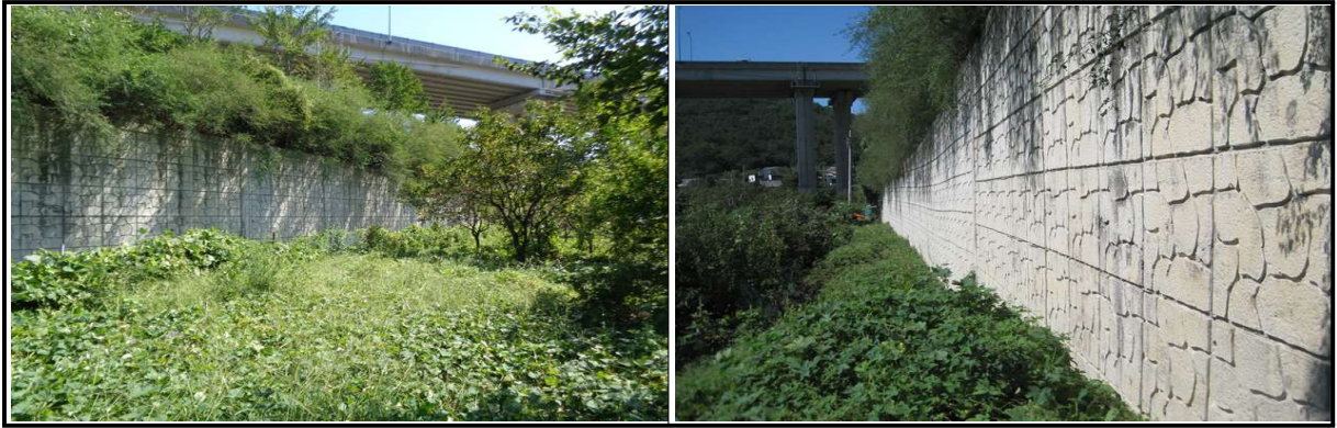
【그림 11.3.1】 전면부 전경(콘크리트옹벽)
